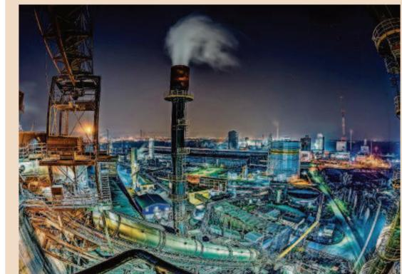
Die Stahlwerke Bremen breiten sich auf einer Fläche von sieben Quadratkilometern aus. 3500 Mitarbeiter sind dort beschäftigt. Jetzt erfinden sich die Stahlwerke neu. Mit Wasserstoff soll grüner Stahl hergestellt werden. Foto: Arcelormittal
